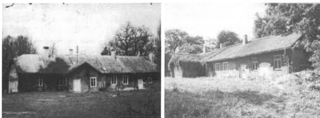
Dwór parterowy w Radestowie w latach 50-tych i 80-tych XX w.) (zabytek.pl)
